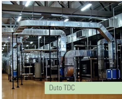
Os dutos POWERMATIC podem ser fabricados em aço carbono, galvanizado, inoxidável ou alumínio. As uniões entre os dutos podem ser através de flange tipo TDC, perfil POWERMATIC ou flanges soldadas. Já o fechamento dos dutos pode ser por cravamento tipo pittsburgh ou solda.
